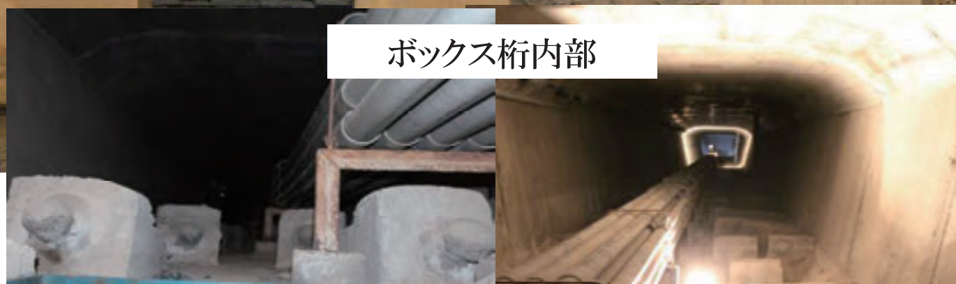
事例③ 大淀大橋 宮崎市 県道341号線
